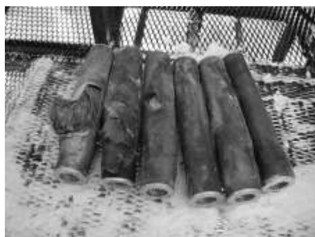
Rys. 10. Zniszczone filtry importowane Fig. 10. Destroyed imported filters
