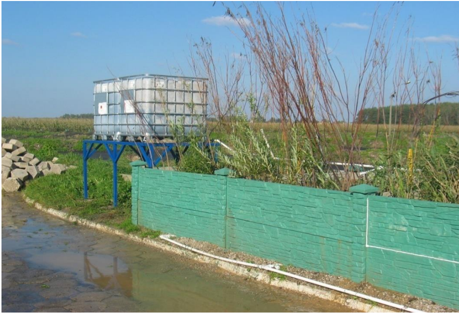
Fot. 1. Instalacja badawcza w połowie okresu wegetacyjnego – 1-szy rok (Boruszko)
